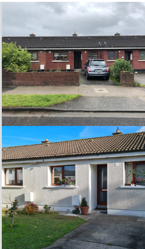
Cúirt an Droma Ghlais roimh agus tar éis uasghráduithe ar Éifeachtúlacht Fuinnimh
